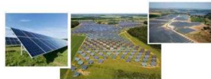
Exemples d'installation PV au sol
