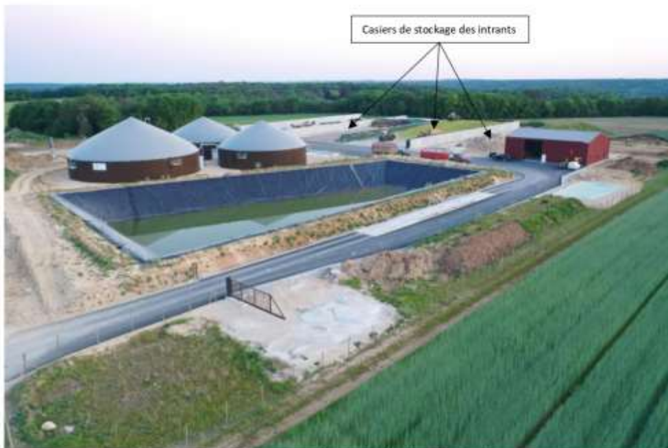
Photographie 1 : Vue aérienne du site de méthanisation
