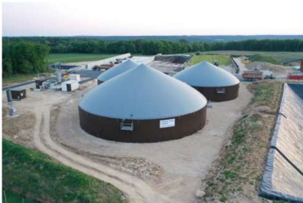
Photographie 2 : Vue aérienne du site de méthanisation
